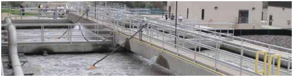
BAS™组合工艺包括一级或一级以上的MBBR移动床生物膜反应器，和后续活性污泥处理系统。高负荷的生物膜处理阶段用于污水的预处理，在活性污泥处理工艺之前去除易生物降解的有机物。
