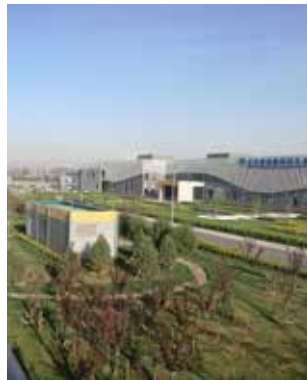
北京槐房再生水厂 ( 中国 ) AQUILAIR™ 化学除臭工艺 ALIZAIR™ 生物除臭工艺 OdoWatch® 臭气实时监测
