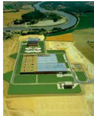
Zaragoza 污水处理厂 ( 西班牙 ) AQUILAIR™ 化学除臭工艺
